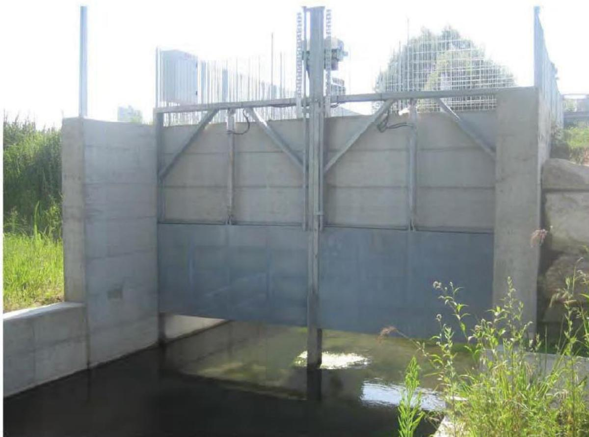
Fig. 12 – Paratoie di regolazione della portata defluente lungo il Canale del Molino
